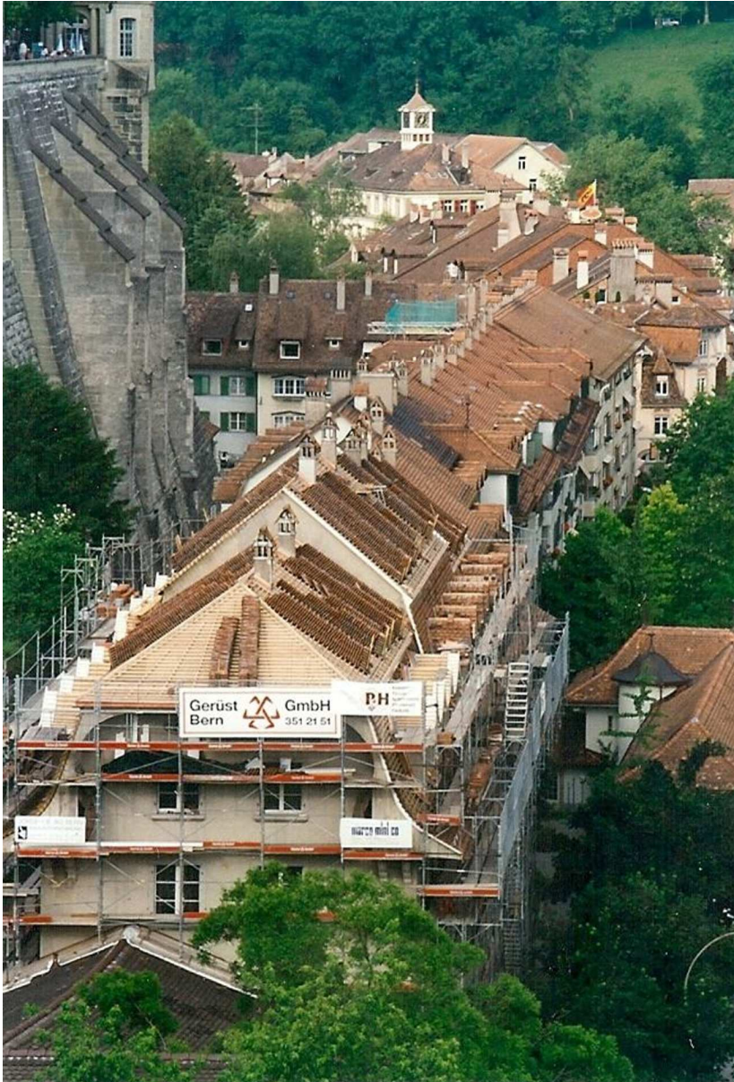
Renovation der Badgasse (ab 1995).
