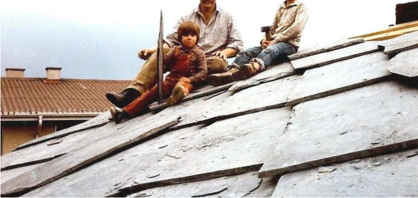
Hans Rudolf Kehrli mit seinen Söhnen Christian (*1979) und Manuel (*1977) beim Eindecken eines Daches mit groben Naturschieferplatten in Toffen (um 1984).
