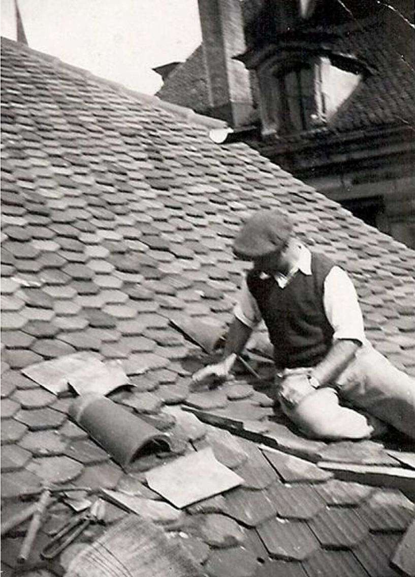
Fritz Johann Kehrli beim Einschroten einer Ziegelkehle an der Hotelgasse, im Hintergrund der Dachstuhl des Zytglogge (um 1960).
