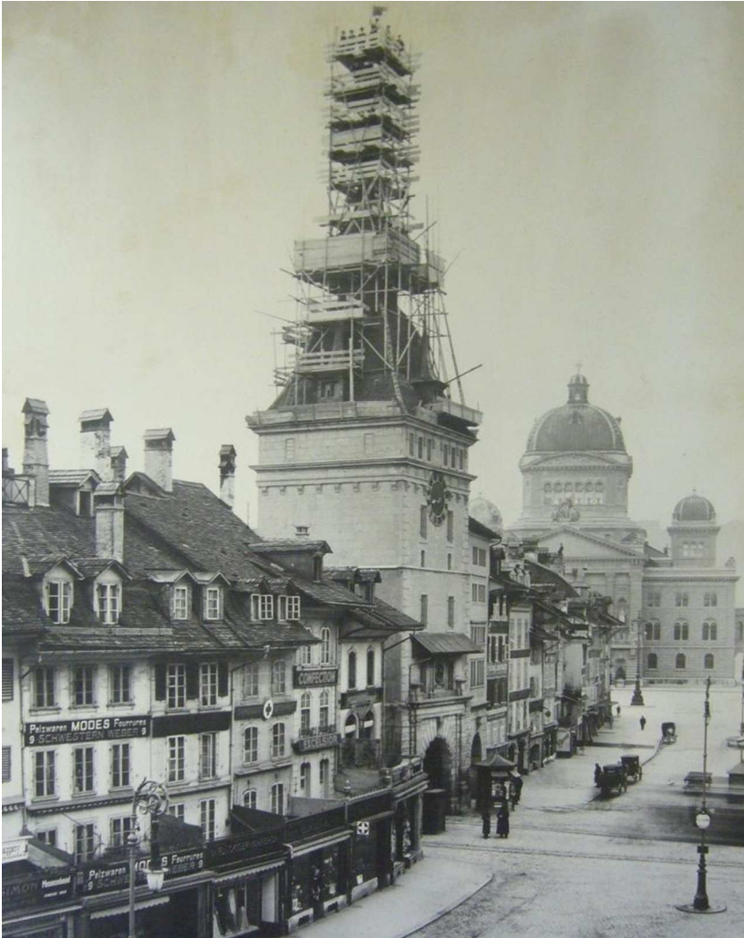
Renovation des Käfigturms 1903 bis 1906.
